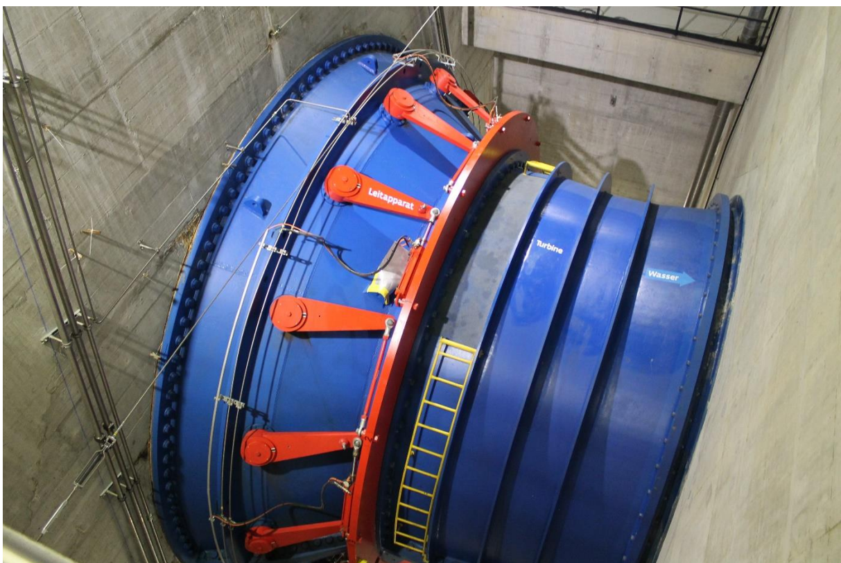
Rohr von aussen mit Steuerklappenregelung!
